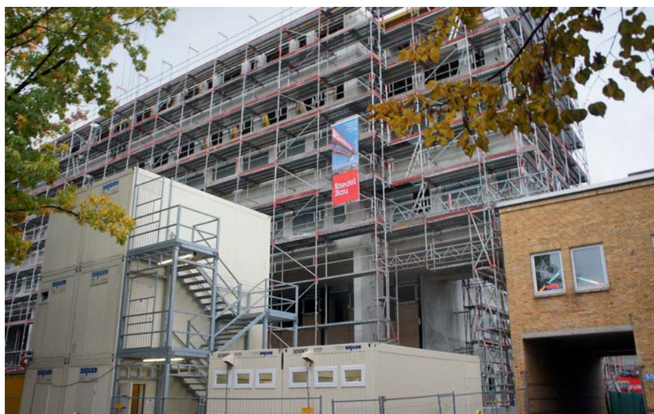
Rohbau des neuen Ärztehauses (Straßenansicht)
