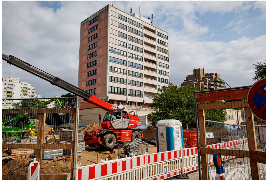
Beeinträchtigungen durch Lärm und Straßensperrung : U-Bahn-Bau vor dem Ärztehaus an der Gründungsstraße
