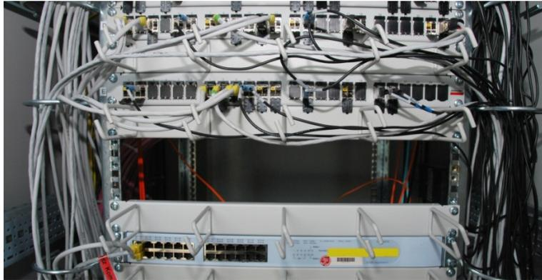
**Abbildung 5** Verteilerschrank eines mittelgroßen Netzwerks mit 2 Verteilerfeldern (oben) und Netzwerkschwitch (unten)
