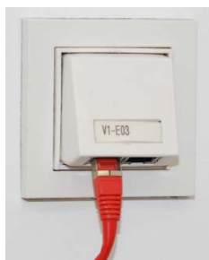
Abbildung 2 Kategorie 6 Datenanschlussdose mit zwei RJ-45 Buchsen
